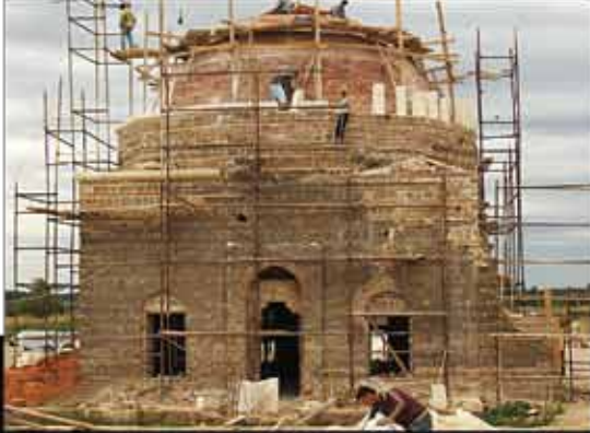
Edirne Timurtaş Camii Restorasyonu
