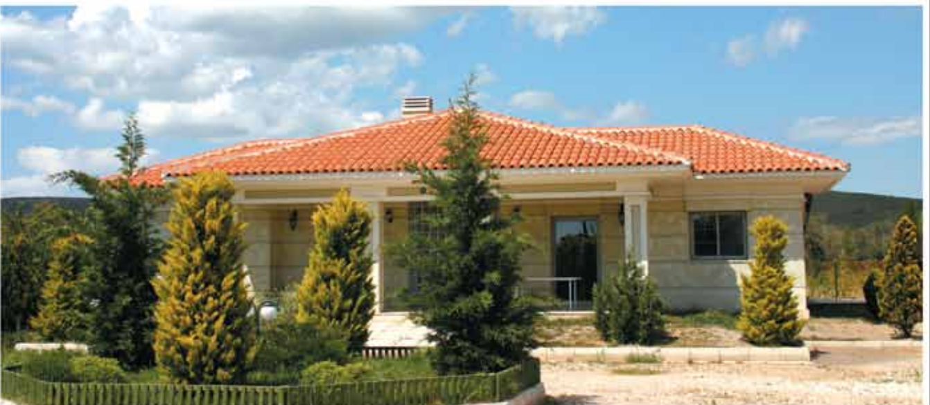
Oluklu Gofrajlı Kiremit Uygulaması
