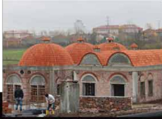
Oluklu Gofrajsız Kiremit Uygulaması Gölcük / Ilıca
