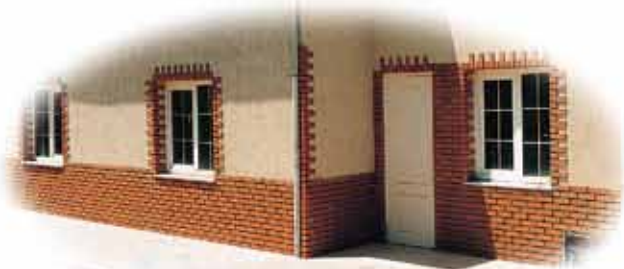
Cephe Kaplama Tuğla Uygulaması
