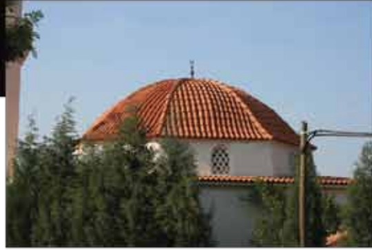
Küçük Oluklu Kiremit Uygulaması
