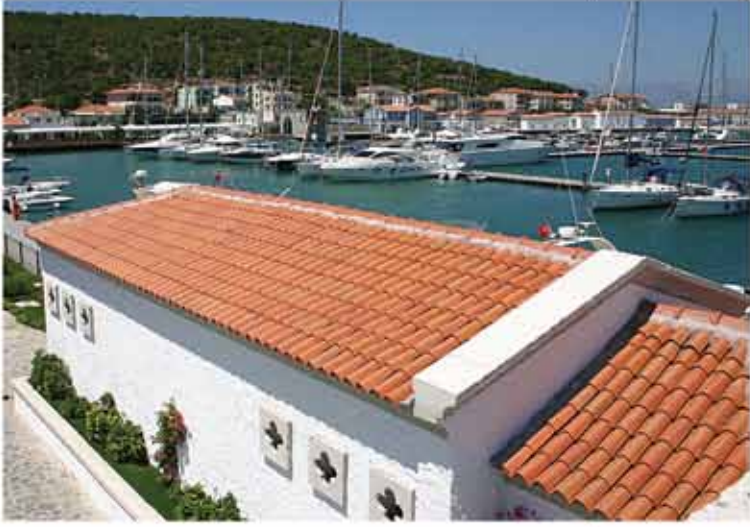
Çeşme Marina Oluklu Gofrajlı Kiremit Uygulaması
