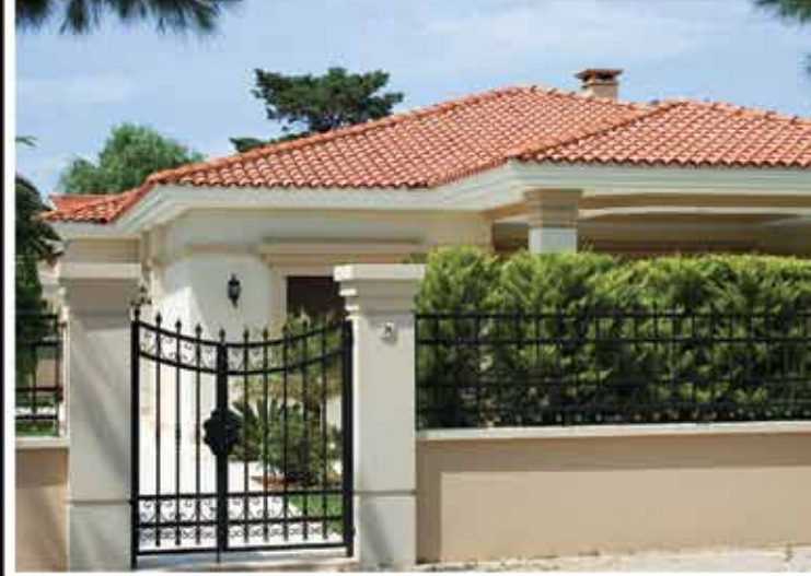
Oluklu Gofrajsız Kiremit Uygulaması
