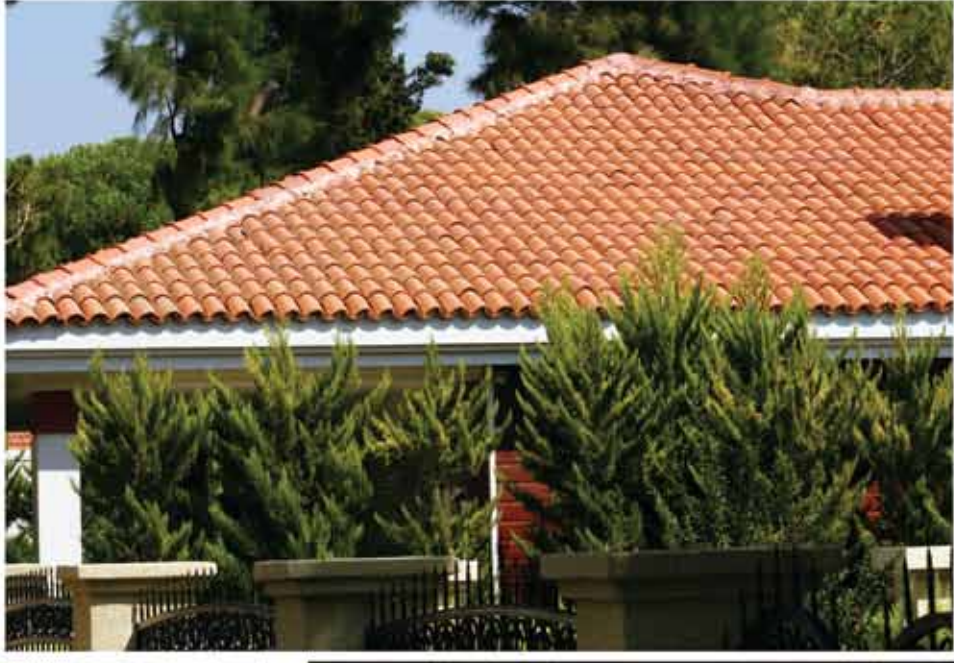
Oluklu Gofrajlı Kiremit Uygulaması
